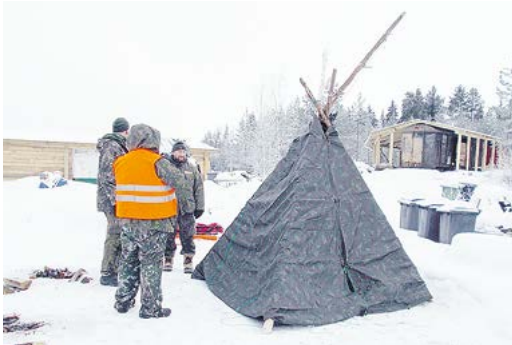
Harvinaisempi rakennelma ilman keskisalkoa; kahdesta 3x3 metrin laavukankaasta tehty kota, jossa pohjapinta-ala on suorakaide, kulmissa on puurangat. Sisätilaa riittää.
