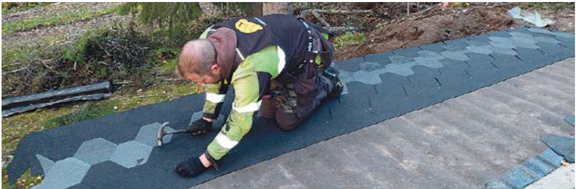
Lauri Mikkonen naputtelee uutta kattohuopaa ovea suojaavan lipan päälle. Kuva: Tapio Kotipelto.
