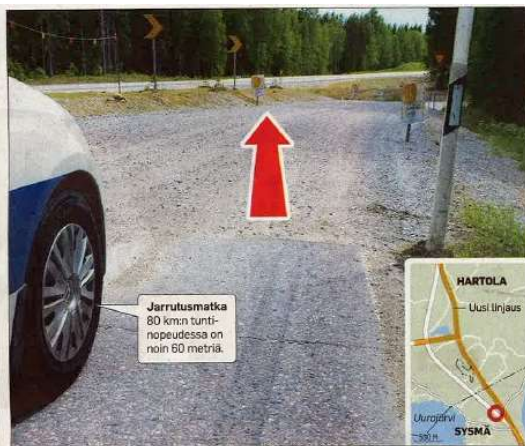
Päälystetty tie päättyy ja vaihtuu murskopinnoitetuksi tieksi hetkeä ennen T-risteystä.
