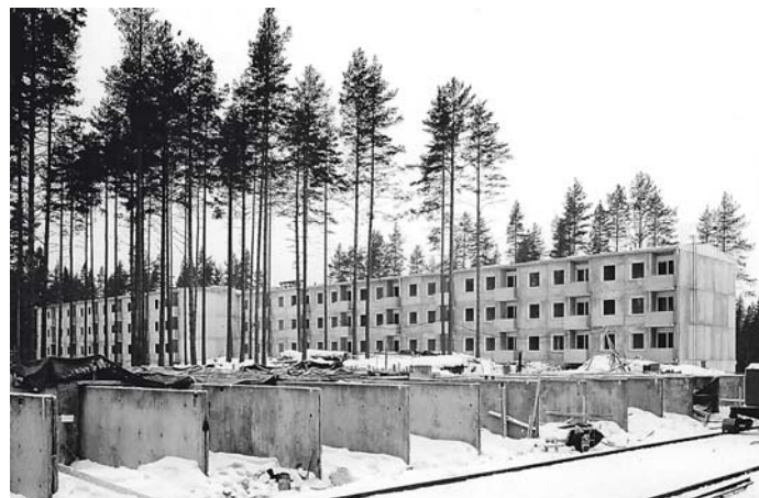
Veteraanitalo valmistumassa Multisiltaan 1969.
